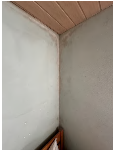
Bild 35 – Schimmel in Außenwanddecke Kind Nordost OG
