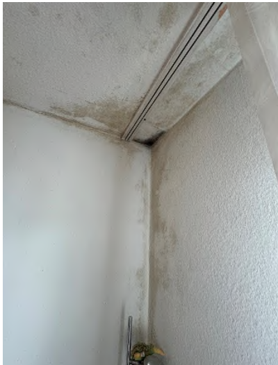
Bild 34 – Schimmel in Außenwanddecke Eltern OG
