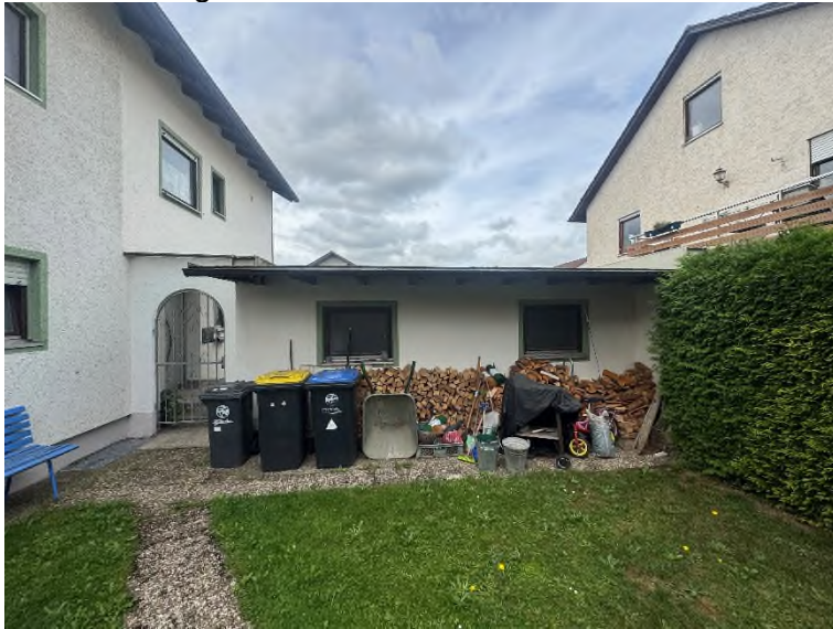
Bild 9 – Blick auf Blechdach Garage
