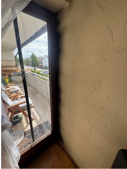
Bild 32 – Schimmel in Fensterleibung Kind Süd OG
