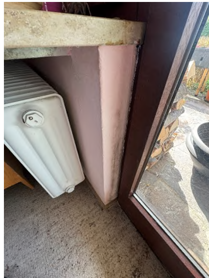
Bild 29 – Schimmel an Außenwand und Decke Speis OG
