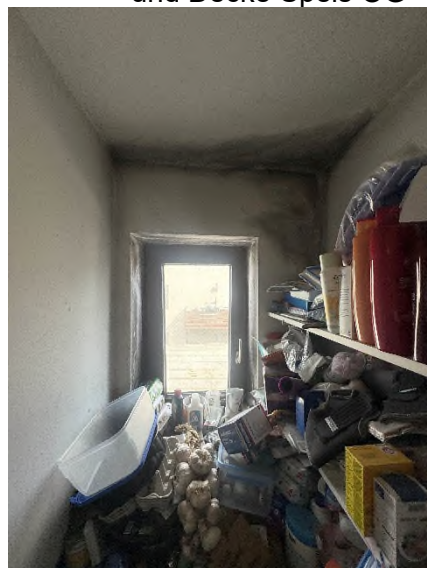
Bild 29 – Schimmel an Außenwand und Decke Speis OG
