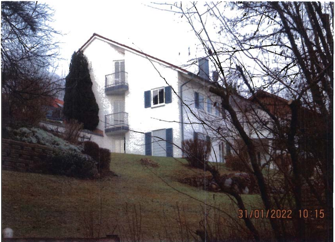
Nord- bzw. Westansicht
