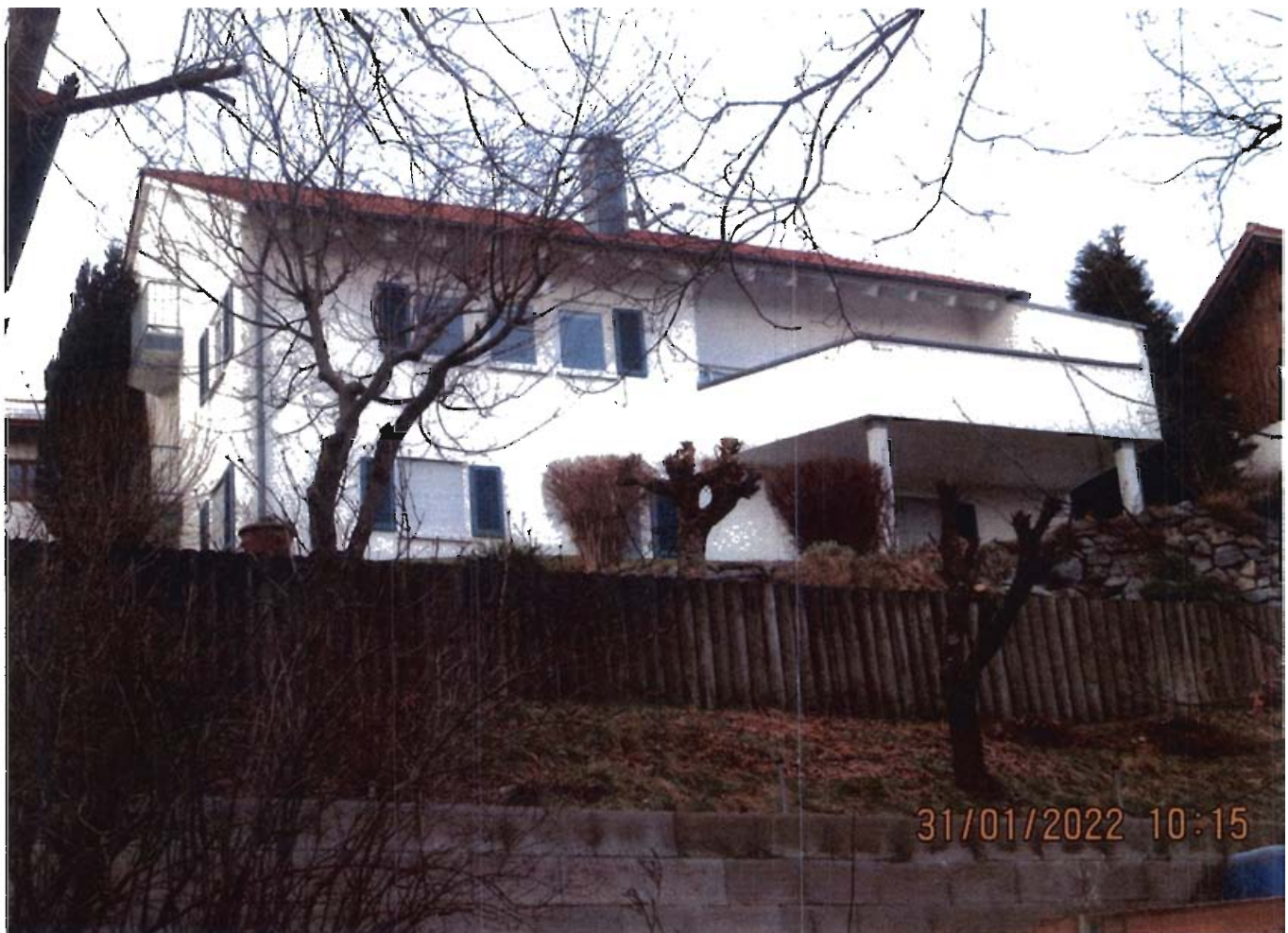
Westansicht mit Hangsicherung
