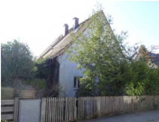
Nordwest- und Nordostseite des Gebäudes
