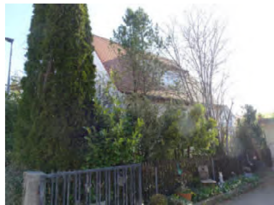
Nordwest- und Südwestseite des Gebäudes
