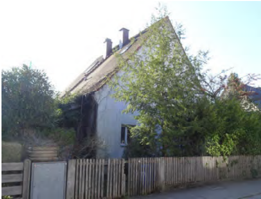
Nordwest- und Nordostseite des Gebäudes
