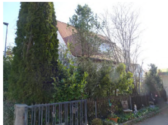
Nordwest- und Südwestseite des Gebäudes
