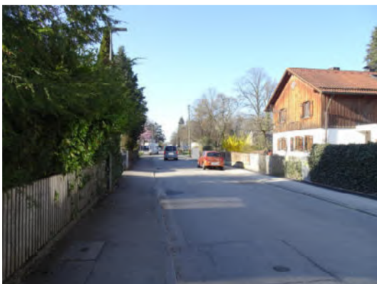
Damaschkestraße – Blickrichtung Südwest
