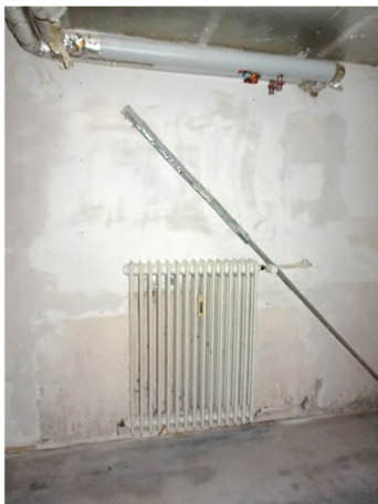
Heizkörper/offene Installation
