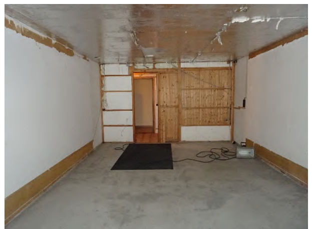
Hobbyraum, Blick zum Vorraum
