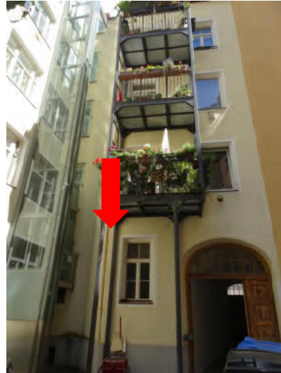
Hofseite des Gebäudes
