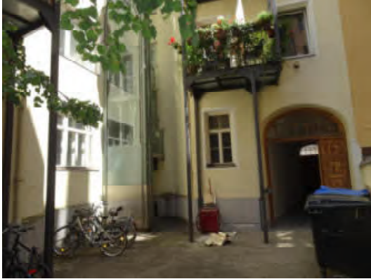
Hofffläche mit Zugang zur Straße
