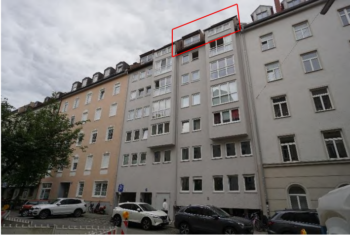
Blick von der Reifenstuelstraße Südwestseite
