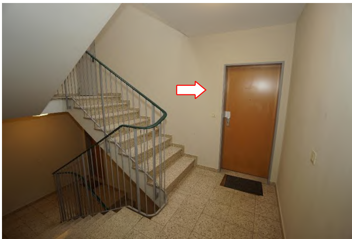
Treppenhaus 1. Dachgeschoss Wohnungseingangstür Nr. 19
