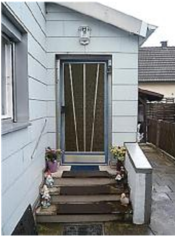
Hauseingang v. Südosten
