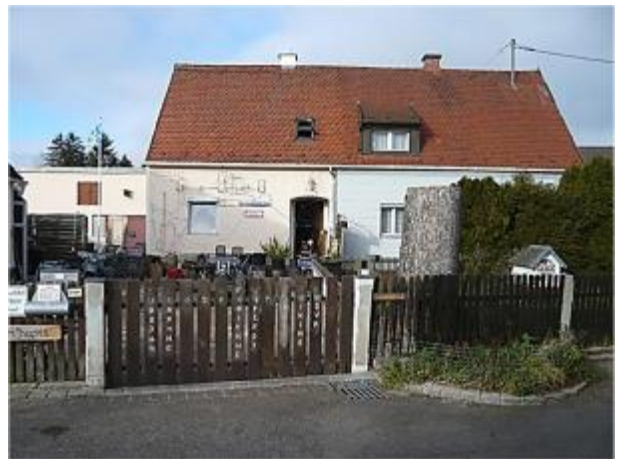
Ansicht v. Südosten
