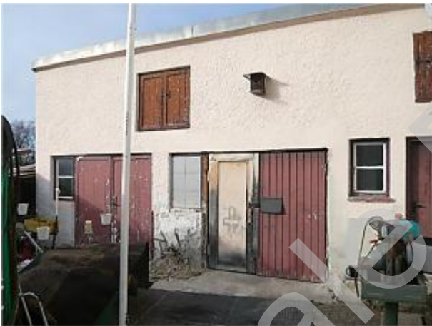
Ansicht v. Südosten
