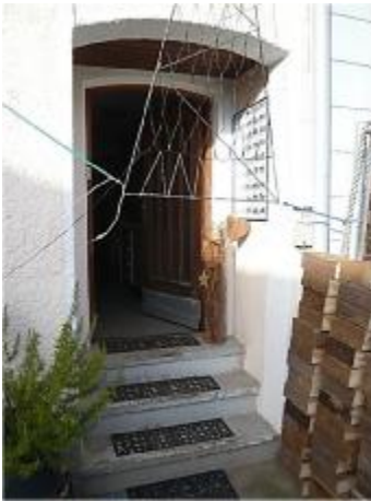
Eingang v. Südosten
