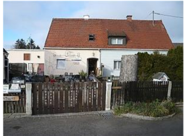
Ansicht v. Südosten
