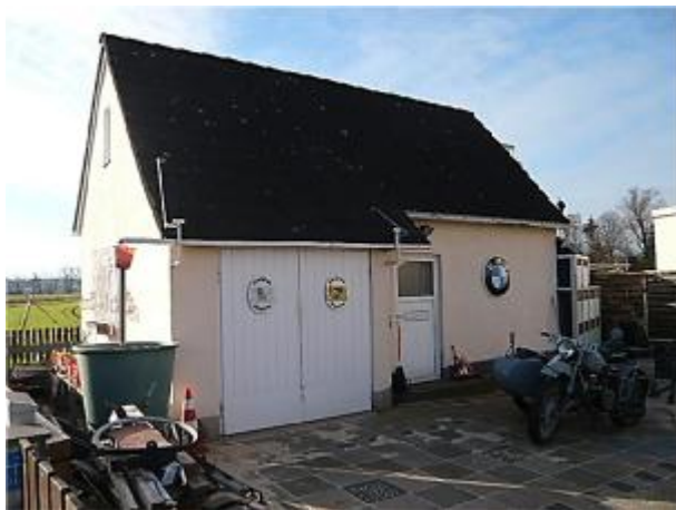
Werkstatt, Ansicht v. Nordosten
