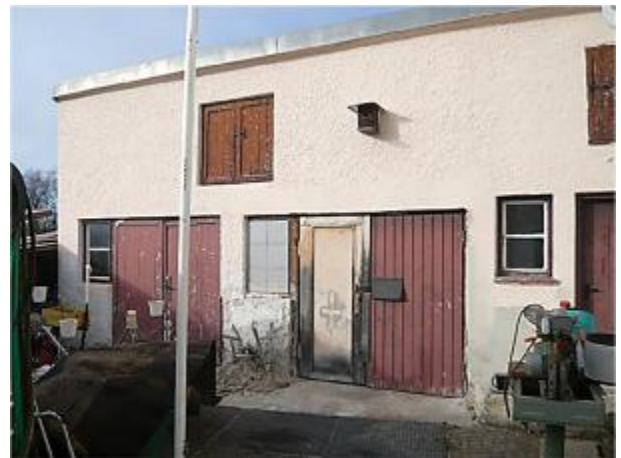
Garagenanbau, Ansicht v. Südosten
