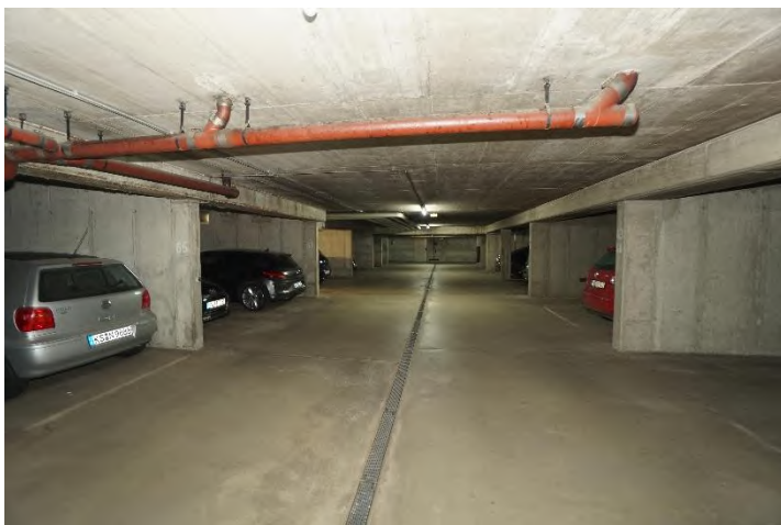
Tiefgarage der Wohnanlage
