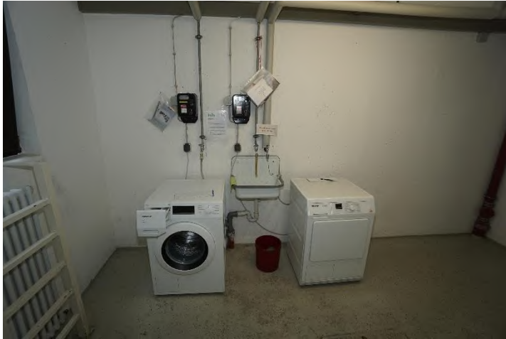
Waschraum im Kellergeschoss
