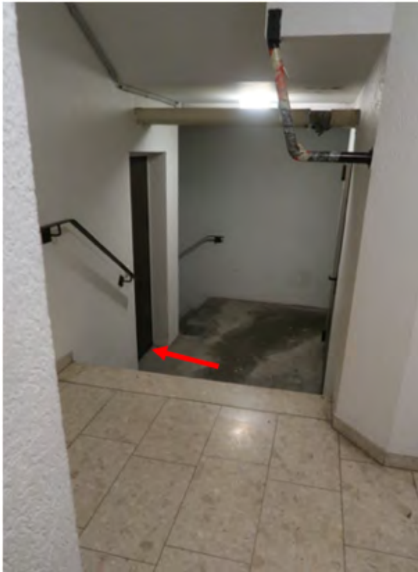
Zugang zum Lager vom Treppenhaus aus, Einheit 1
