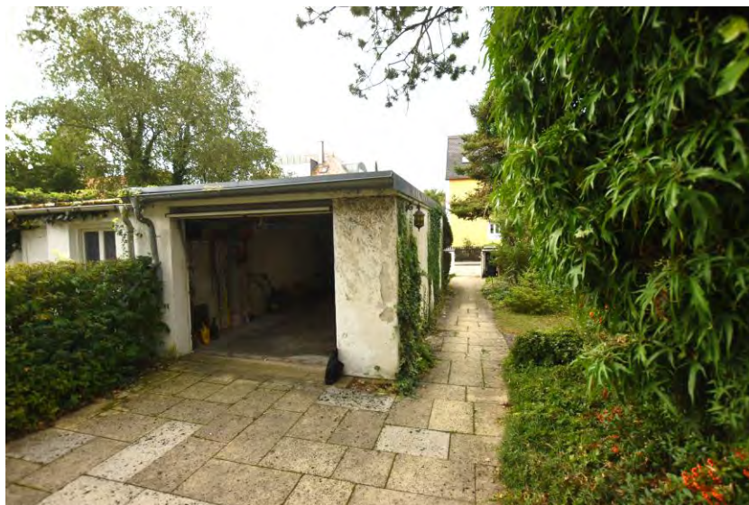
Nordansicht des Garagengebäudes
