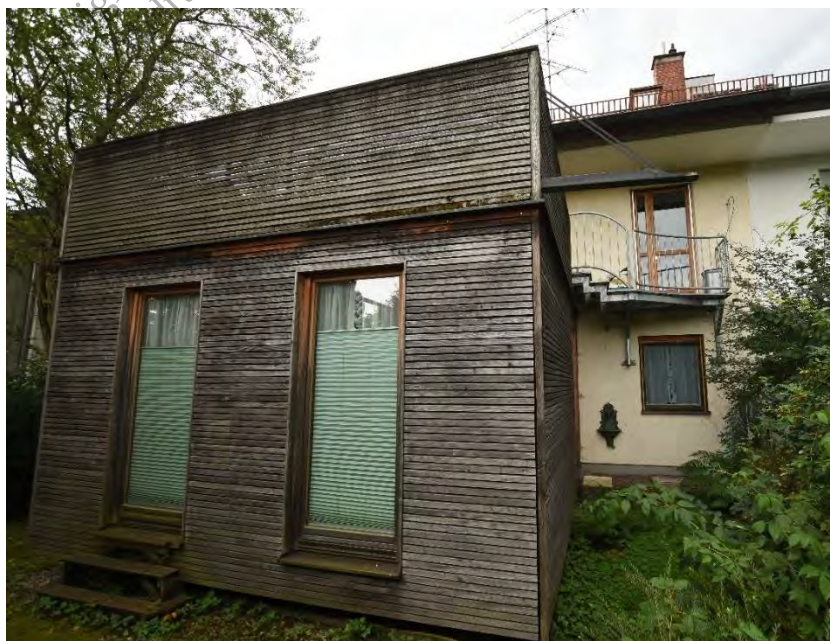
Nordansicht des Anbaus
