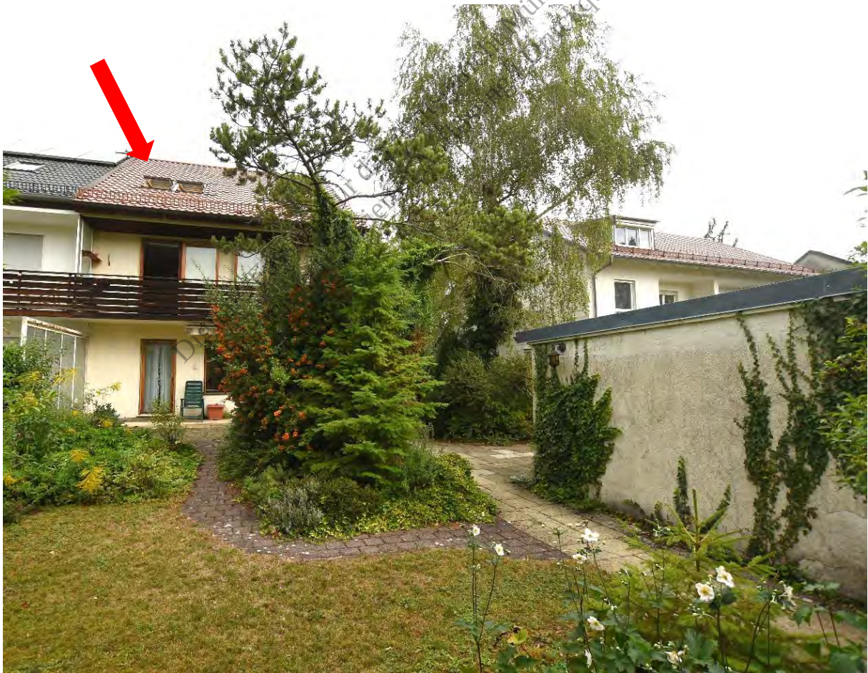
Südansicht des Wohnhauses und Westansicht des Garagengebäudes
