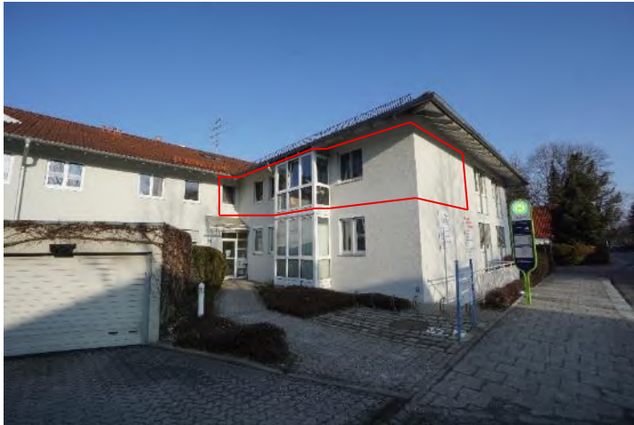
Blick aus Richtung Süden
