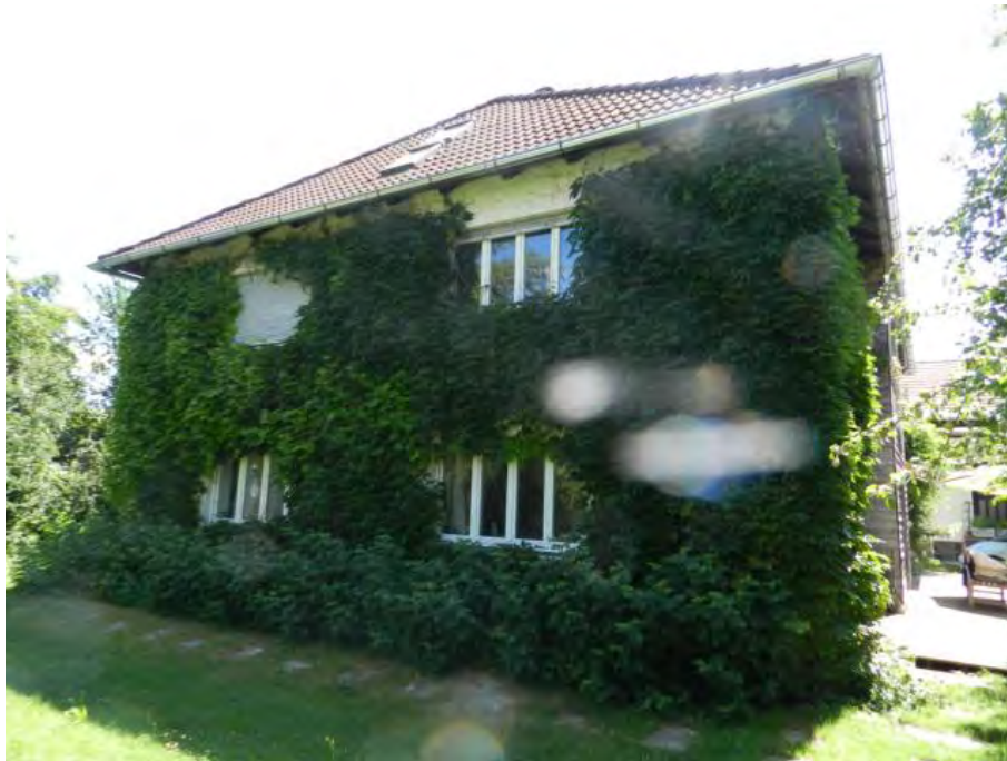
Wohnhaus (BK 1), Ansicht von Nordwest
