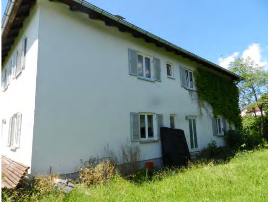
Wohnhaus (BK 1), Ansicht Nordostfassade
