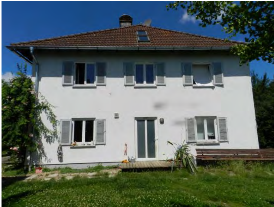
Wohnhaus (BK 1), Ansicht von Südost
