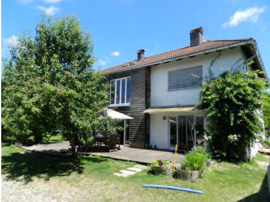
Wohnhaus (BK 1), Ansicht Südwestfassade
