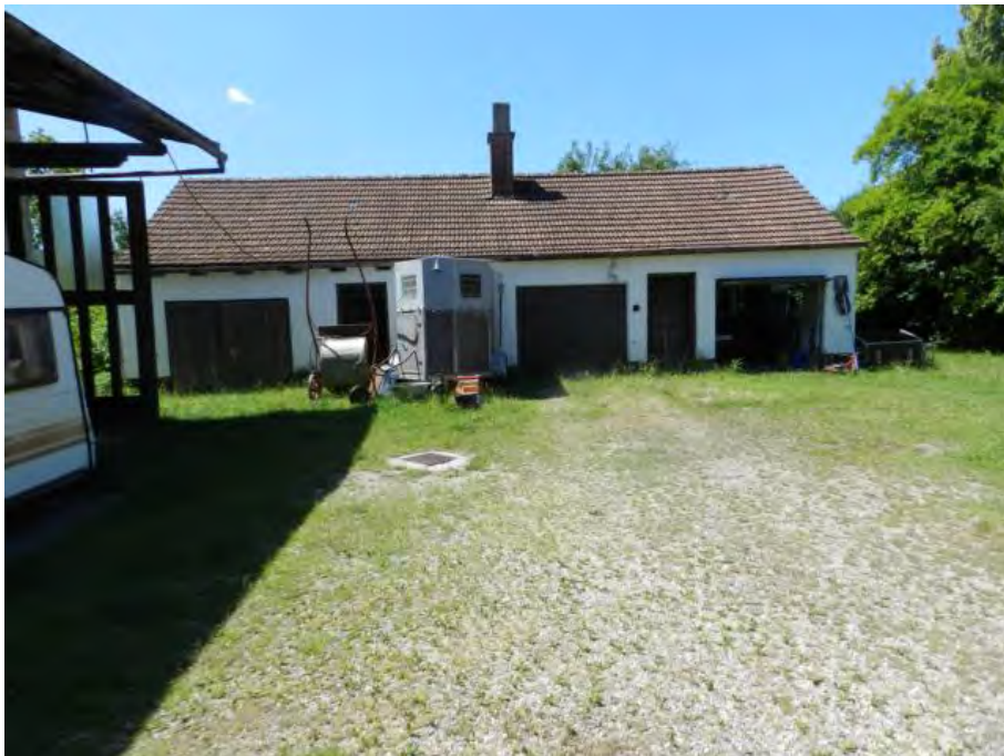
Garagegebäude (BK 3), Ansicht von Nordost
