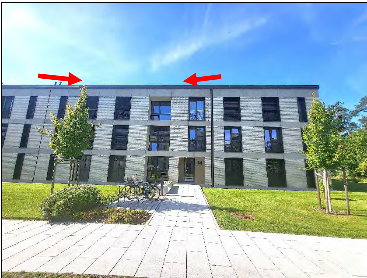
Vorderansicht des Gebäudes Apfelwiese 14 (Baujahr 2023); die ETW Nr. 71 befindet sich im DG (siehe Pfeile)
