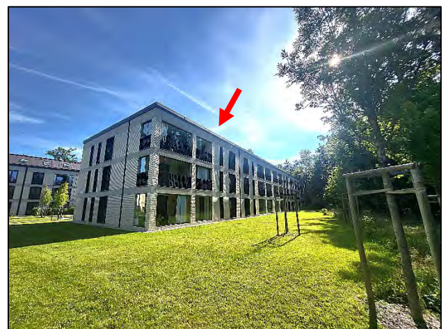
Gebäuderückansicht; direkt südlich angrenzend beginnt ein Waldgebiet (Blick ins Grüne)
