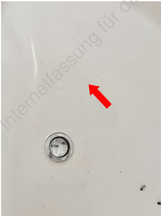
Foto 28: Beschädigung am Waschbecken
