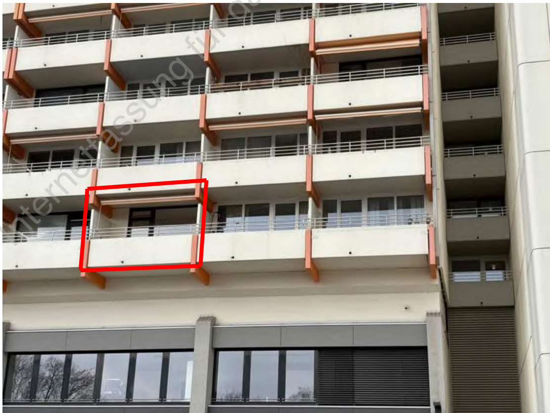
Foto 9: Apartment Nr. 60 im 2.OG
