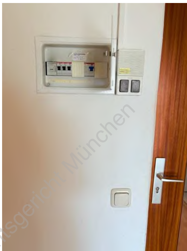
Foto 18: Unterverteiler
