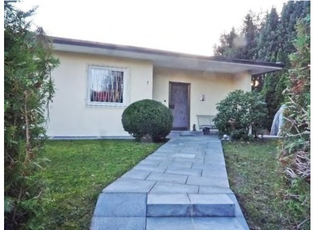
Zugang von Norden
