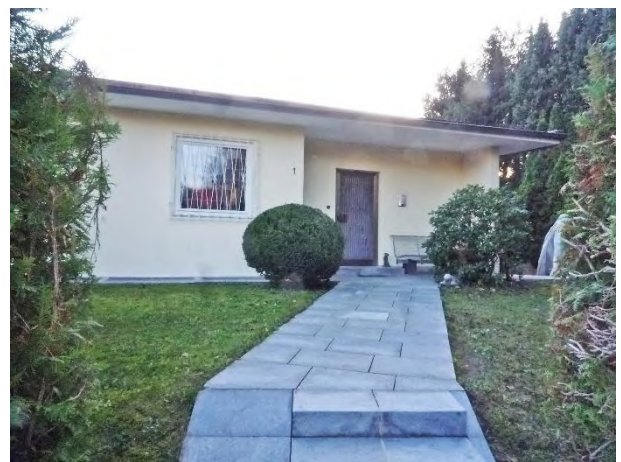
Zugang von Norden
