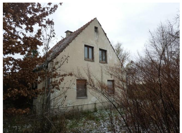
Ansicht von Südosten
