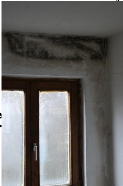
Feuchteschäden im Wandbereich
