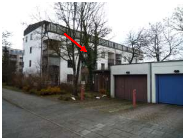
Ansicht von Nordwesten, TG-Zufahrt
