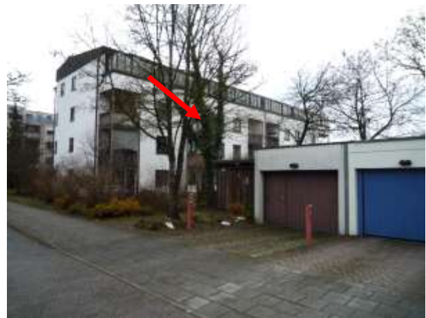
Ansicht von Nordwesten, TG-Zufahrt
