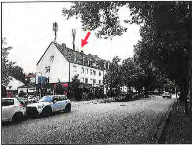
Blick in die Senftenauerstr. in südöstliche Richtung; das WGH liegt an der Nordseite (siehe Pfeil)
