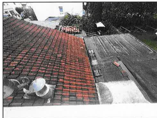
Blick vom DG aus auf die Dachkonstruktionen der beiden nördlichen Anbauten
