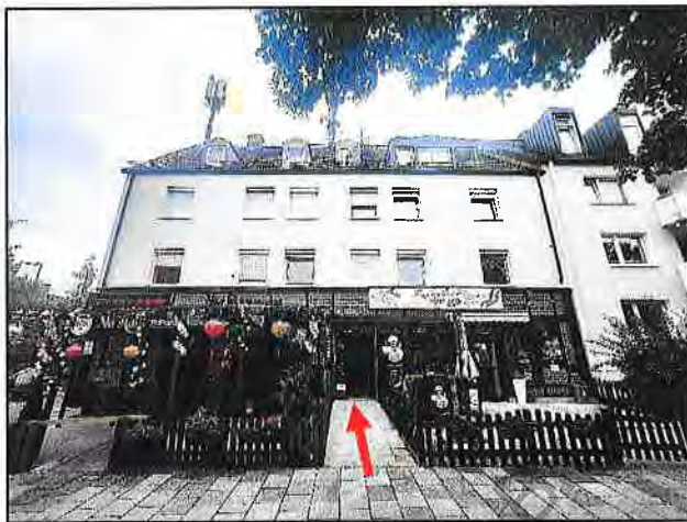
Vorderansicht des Gebäudes mit Gastronomie- einrichtungen im EG; in der Mitte Hauseingang
