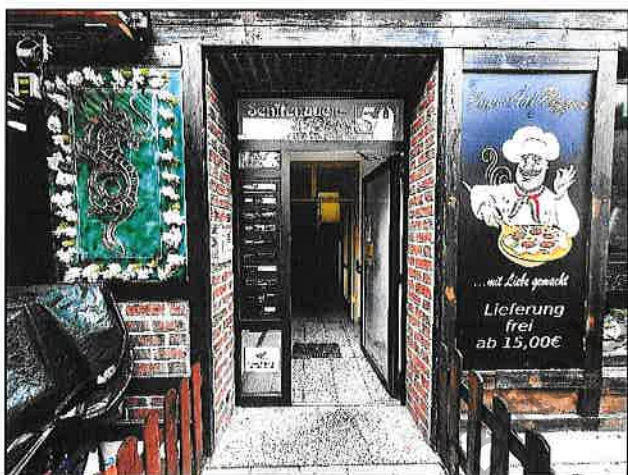
Überdachter Hauseingang; Klingeltableau links; Briefkastenanlage im Türelement integriert
