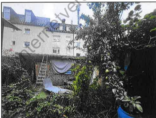
Die nördlichen Anbauten müssen tlw. zurückgebaut werden, der Innenhof muss entsiegelt werden
