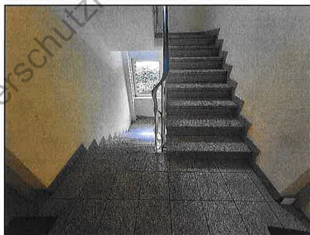
Blick in das Treppenhaus mit Metallgeländer und Kunststoffhandlauf
