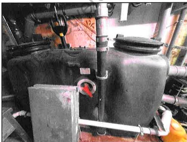
Fettabscheider im KG
