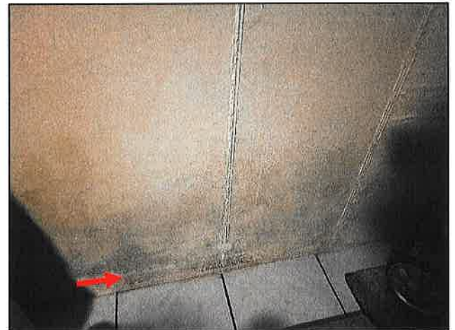
Leichte Feuchtigkeitsschäden im Hobbyraum KG
