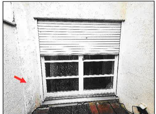
Nahansicht Fensterfront des Wohnzimmers, leichte Putzschäden in der Außenwand
