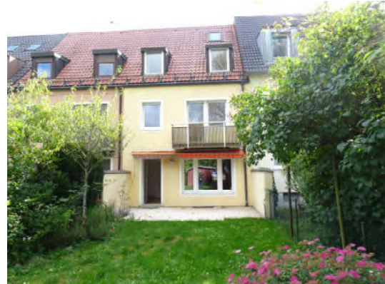
Nordwestseite des Reihenhauses
