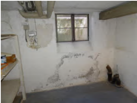
Feuchtigkeitsschäden Keller
