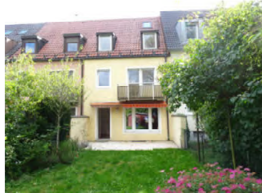
Nordwestseite des Reihenhauses
