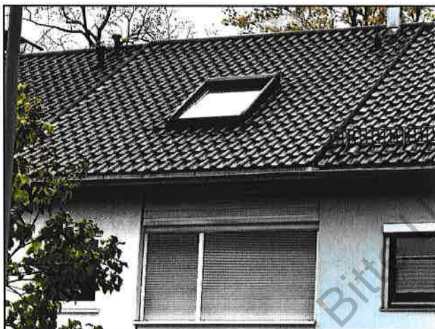
Nahansicht südliche Dachseite; nur Dachliegefenster, keine Gaube, wie bei den Nachbargebäuden
