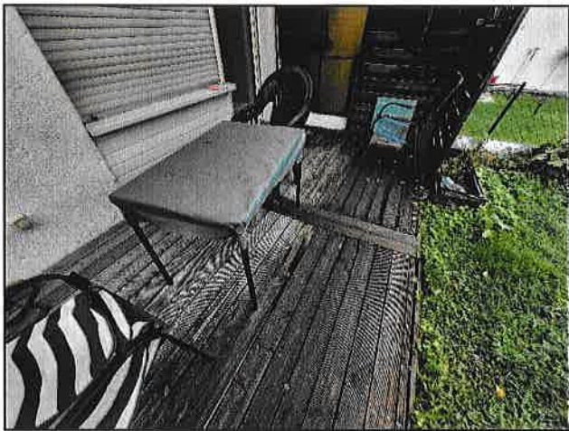
Nahansicht Terrasse; Holzkonstruktion mit sichtbaren Witterungsschäden
