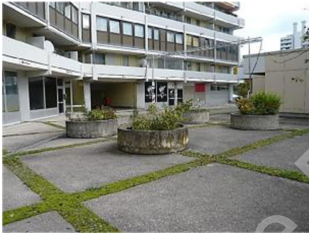
Rückwärtiger Grundstücksbereich (exemplarisch)
