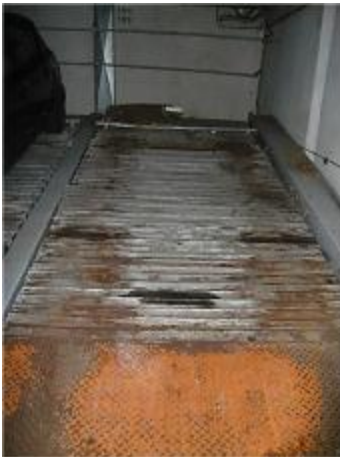
Stellplatzfläche Nr. 190 (exemplarisch)
