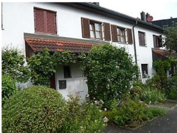
Ansicht v. Südosten
