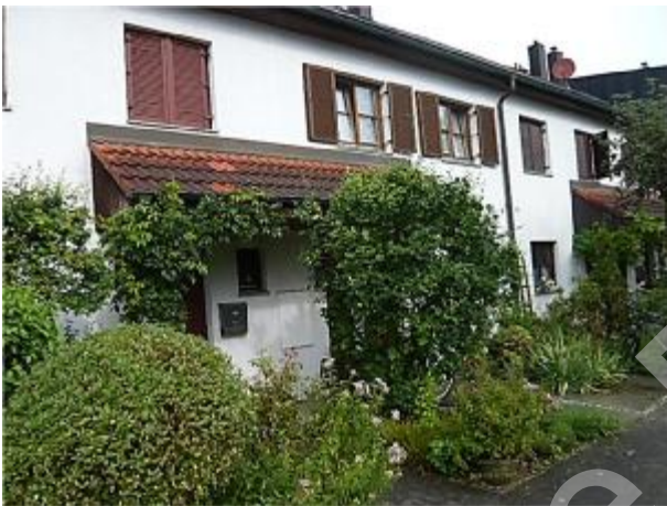
Ansicht v. Südosten
