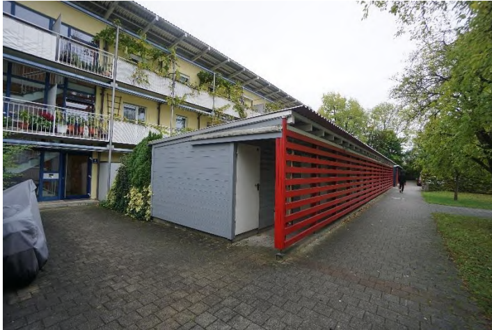
Nebengebäude mit Zubehörräumen
