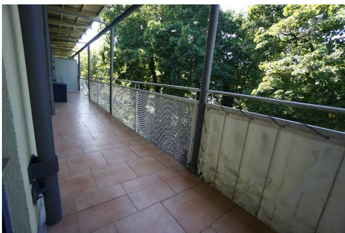
Blick von Treppenhaus auf den Balkon der Wohnung Nr. 68 (Bildaufnahme vom 19.09.2025).
