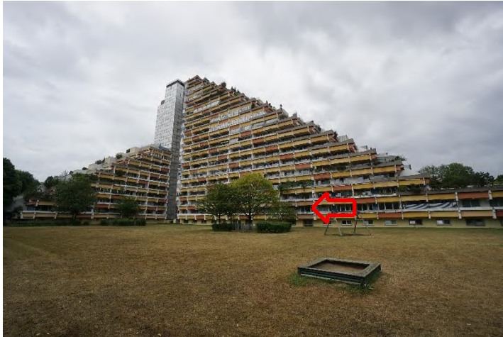
Blick aus Richtung Westen (Bauteil A+B). Der Pfeil deutet auf die Loggia der Wohnung Nr. 16.
