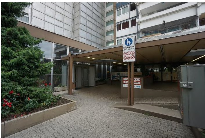
Die überdachte Ladenstraße ist als Fußgängerzone ausgebaut und beginnt unmittelbar am gemeinschaftlichen Hauseingang der drei Wohnhäuser (Bauteil A–C).
