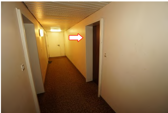
Erschließungsflur Hochparterre (Bauteil A) – Wohnungstür Nr. 16
