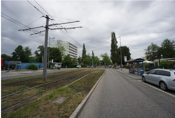
Blick in die Cosimastraße mit zusätzlichem Straßenbahnverkehr.
