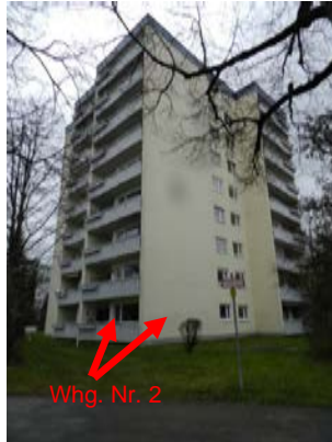
Ansicht von Südost
