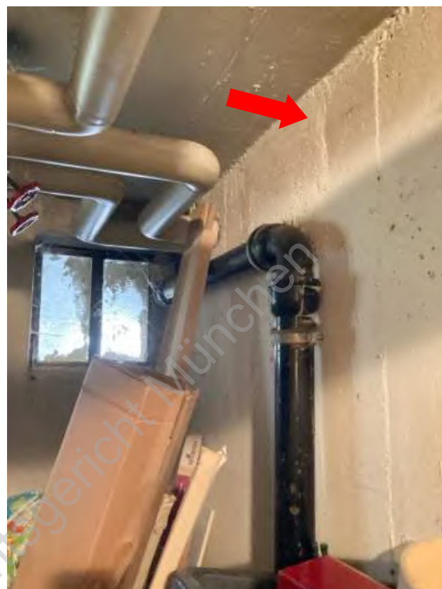
Foto 11: Trennwand zum Keller Nr. 56
