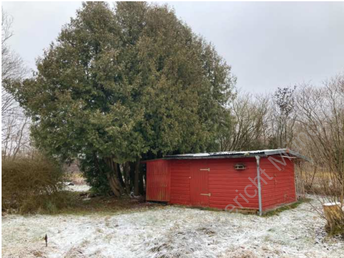
Foto 20: Schwarzbau an der südlichen Grundstücksgrenze
