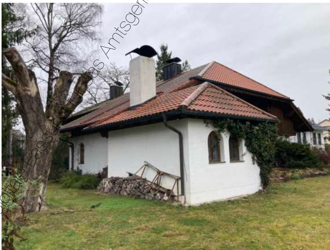
Foto 16: Blick von Südwesten
