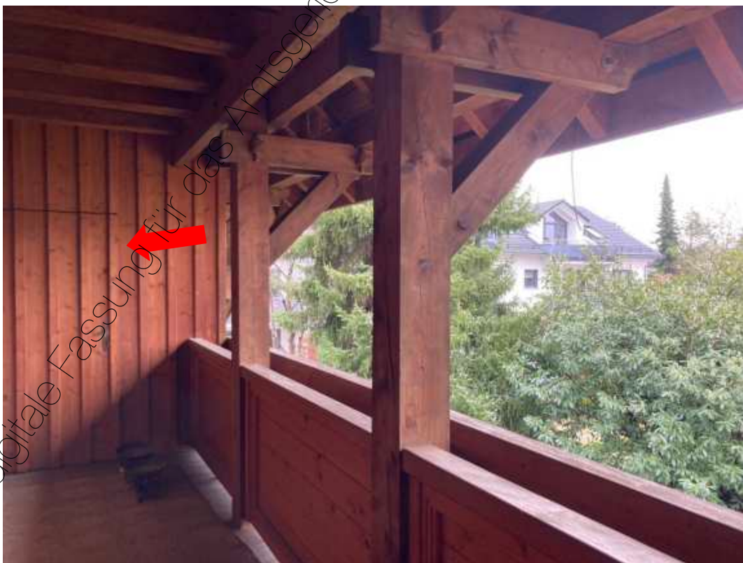
Foto 45: Südbalkon, Zugang zum Abstellraum
