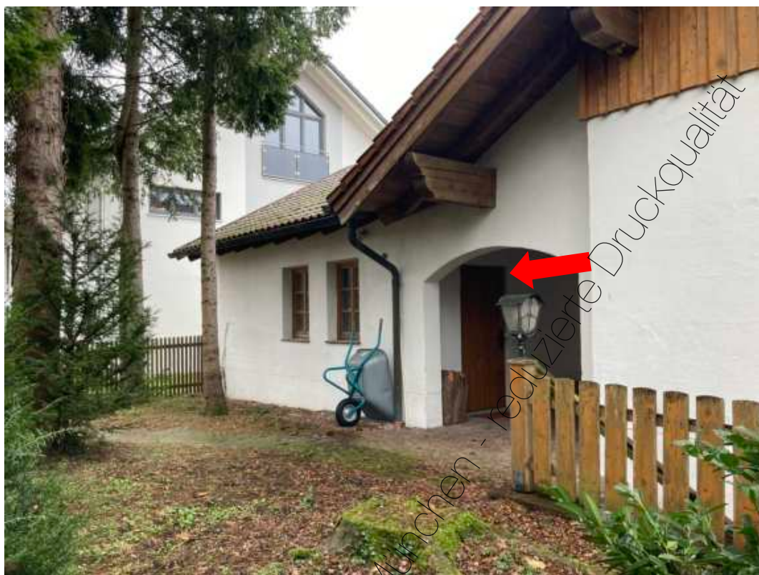
Foto 7: Zugang zur Garage im Durchgang
