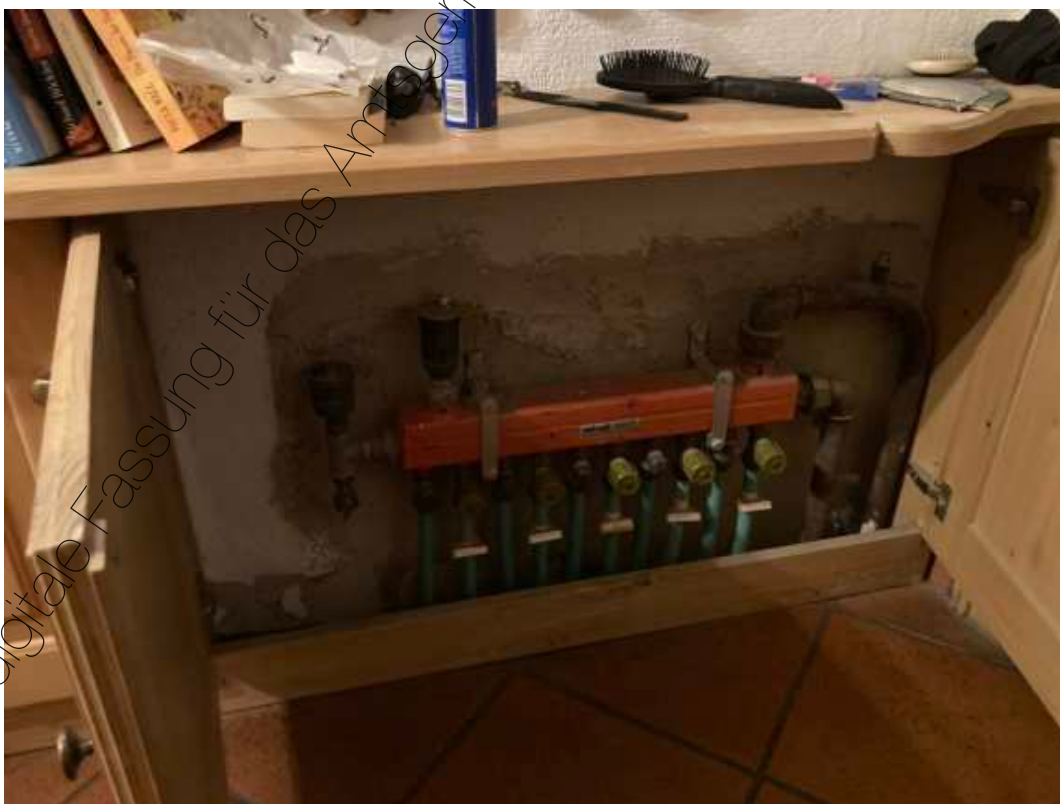
Foto 34: Verteiler Fußbodenheizung
