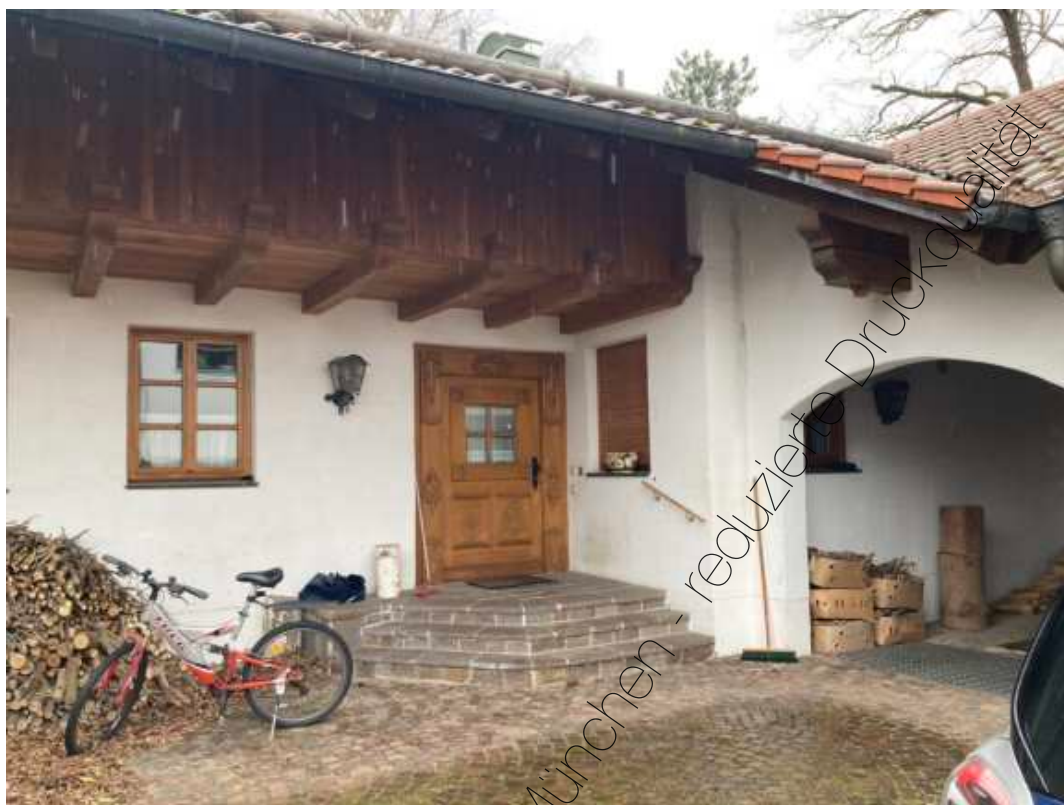
Foto 5: Hauseingang an der Ostseite
