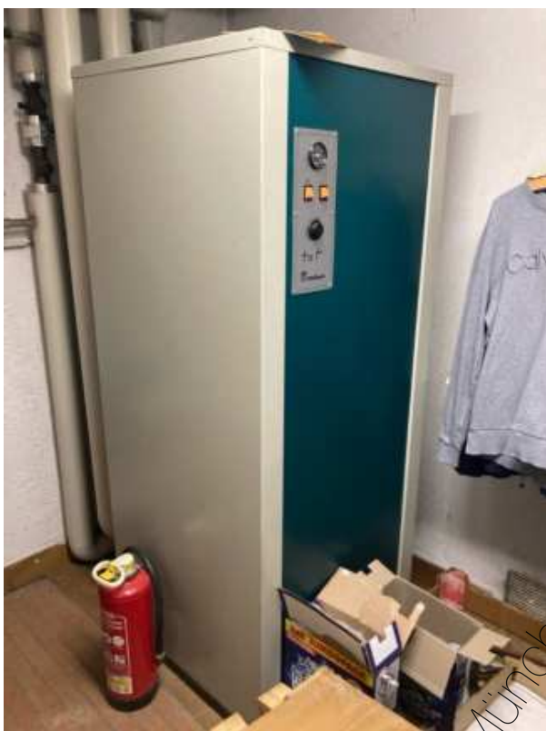
Foto 67: Heizraum, Warmwasserspeicher
