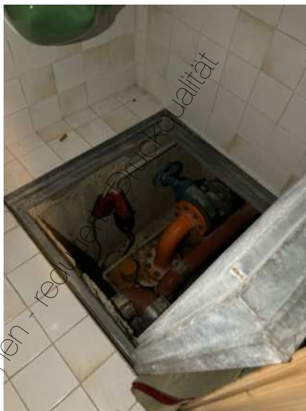
Foto 71: Hebeanlage
