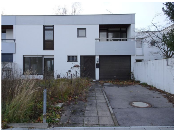
Ostansicht von der Riesheimerstraße
