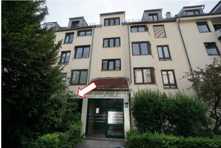
Blick vom Innenhof auf das Gebäude Schleißheimer Straße 63 a – Ostfassade. Links vom Hauseingang liegen die Fensterelemente des Kinder- und Schlafzimmers.
