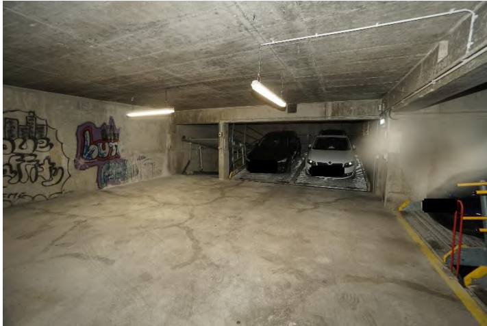
Tiefgarage Schleißheimer Straße 63 a
