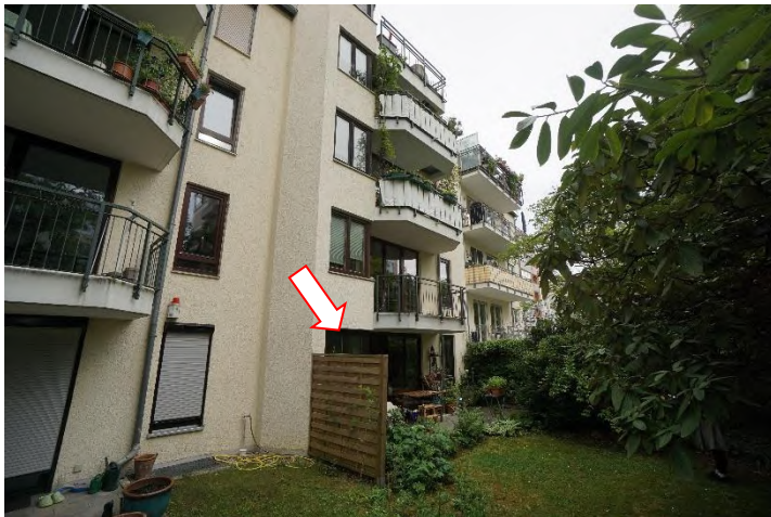
Blick vom Gemeinschaftsgarten – Westfassade. Der Pfeil deutet auf das Küchenfenster der Wohnung Nr. 1.
