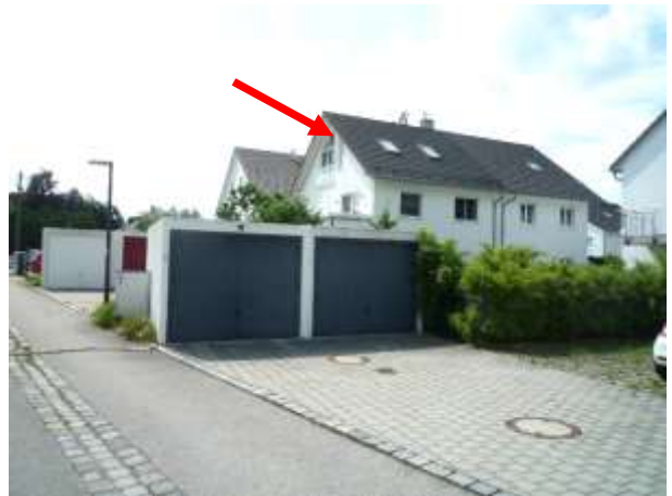
Ansicht von Osten
