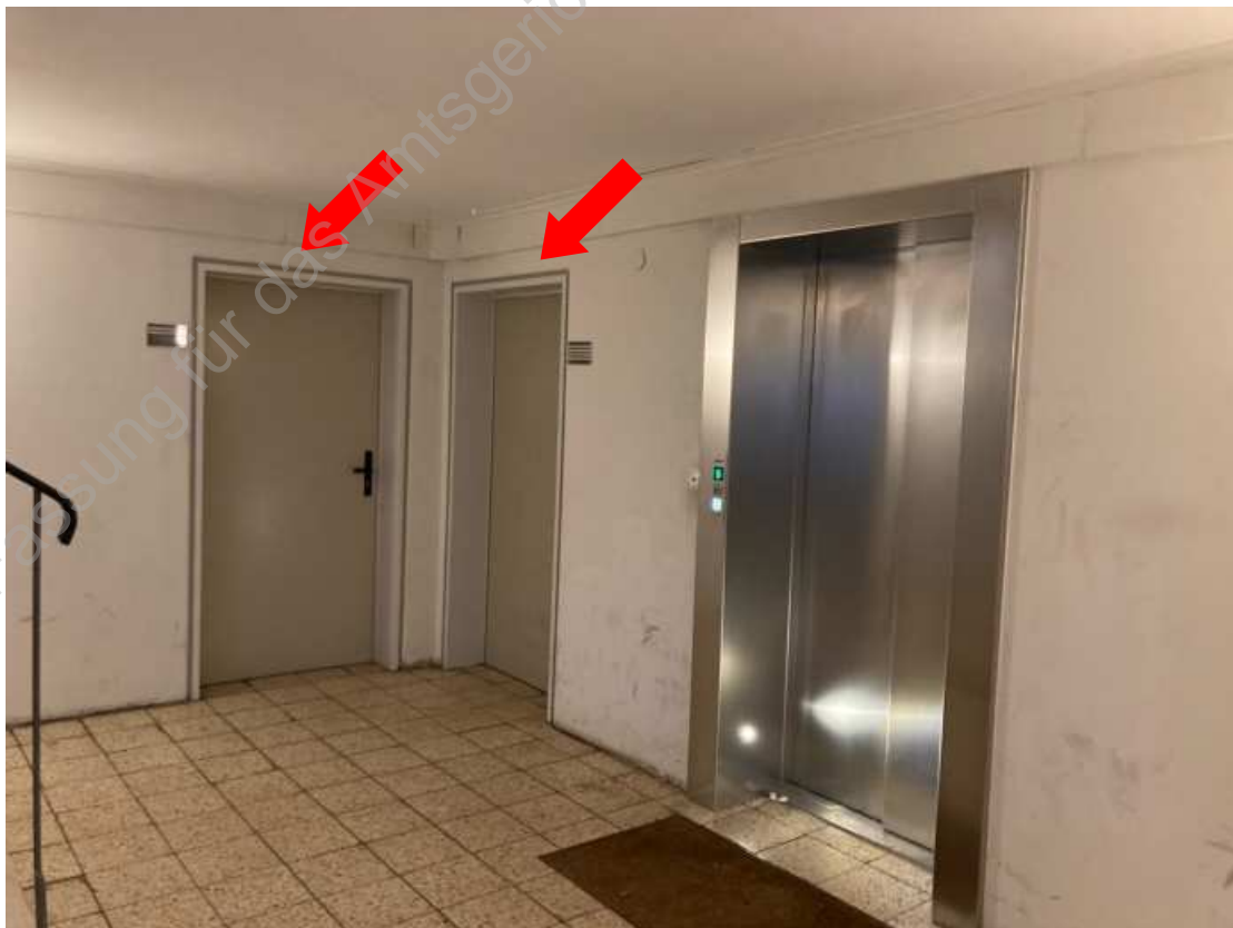
Foto 13: Untergeschoss: Zugang Wasch-/Trockenraum und Fahrradraum
