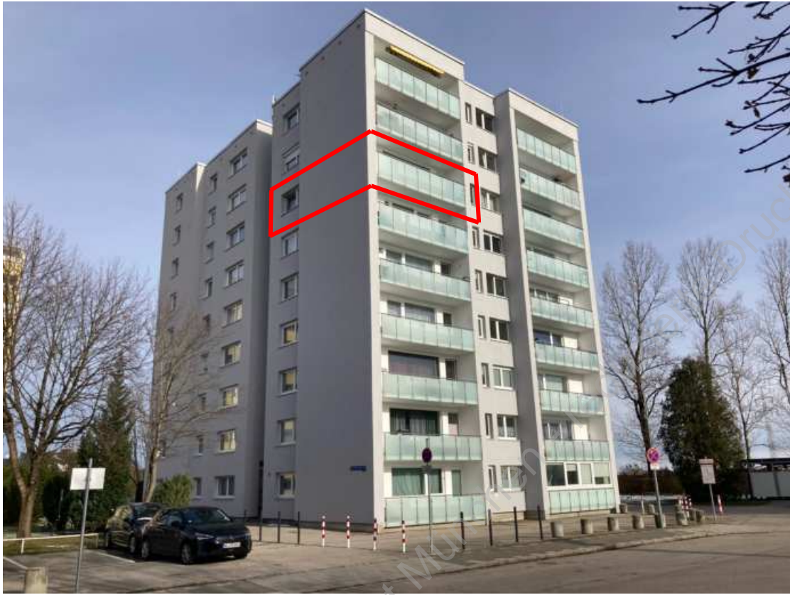
Foto 1: Blick von Südwesten, Haus 1
