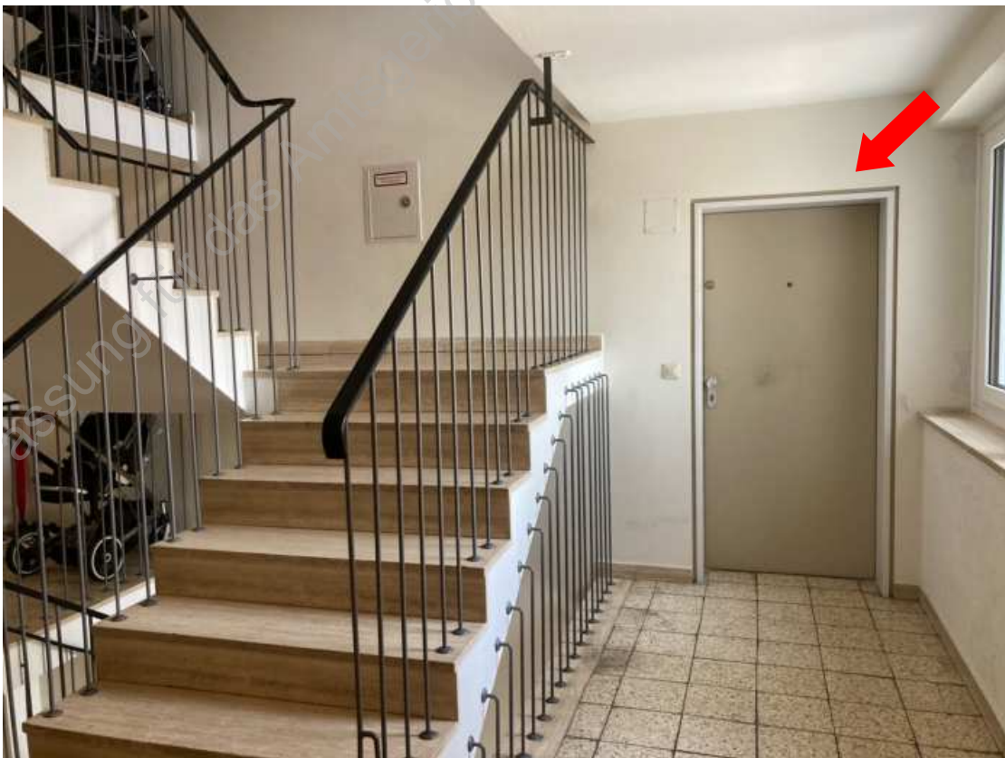
Foto 11: 6. Obergeschoss, Eingang Wohnung Nr. 28
