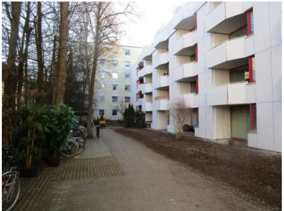
Zugang zu Haus Nr. 11 mit Blick nach Osten
