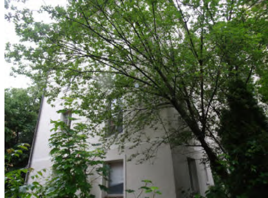
Südwestseite des Gebäudes
