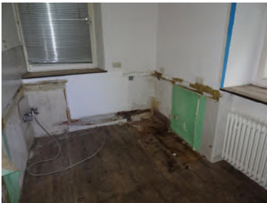
Fläche EG mit ehemaliger Küche
