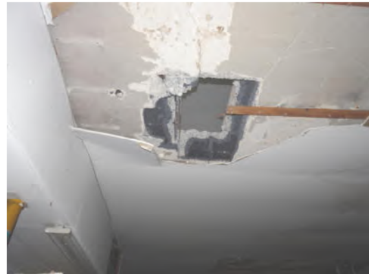
Probeöffnung Decke
