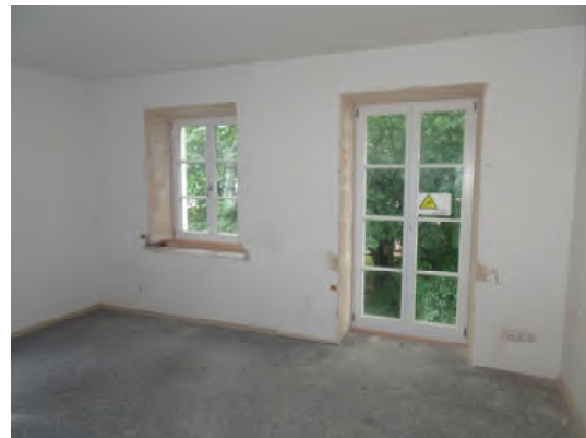
Fläche OG mit neuen Fenstern
