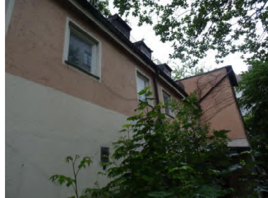
Nordostseite des Gebäudes
