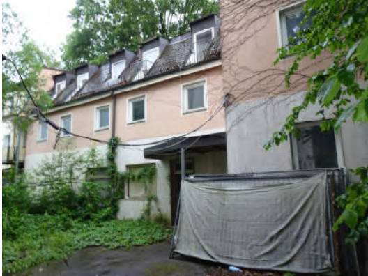
Nordostseite des Gebäudes
