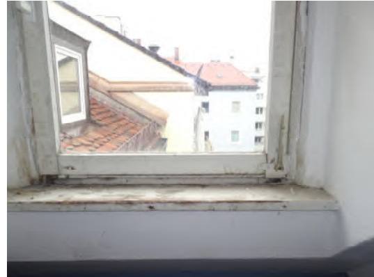
Fenster und Dachflächen DG
