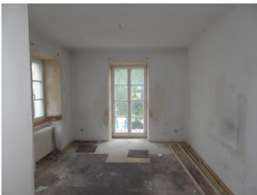
Fläche OG mit neuen Fenstern
