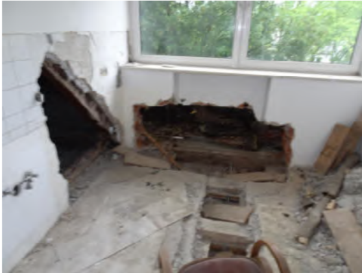
Fläche DG mit Probeöffnung
