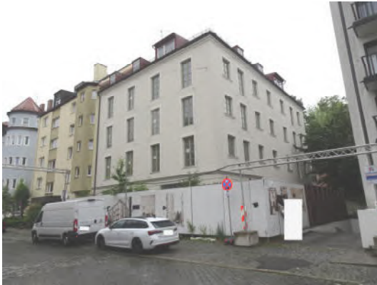
Nordost- und Nordwestseite des Vordergebäudes
