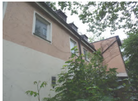
Nordostseite des Rückgebäudes
