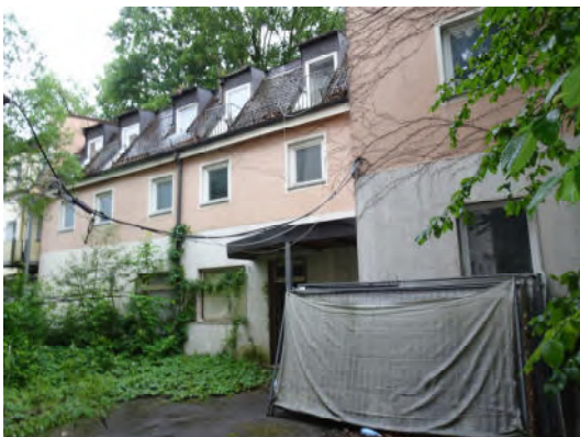
Nordostseite des Rückgebäudes
