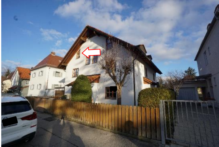
Südwestansicht – Der Pfeil deutet auf das Schlafzimmerfenster.
