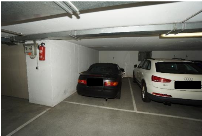
Tiefgaragenstellplatz Nr. 10 (gekennzeichnet mit „4“)
