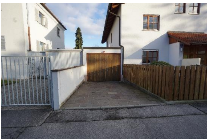
Zufahrt zur Tiefgarage von der Kachletstraße
