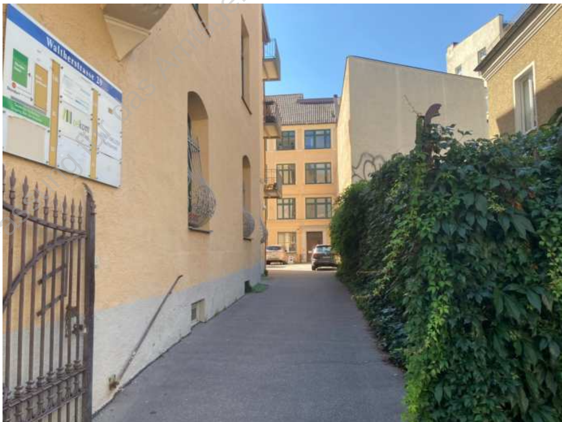
Foto 2: Zugang zum Rückgebäude
