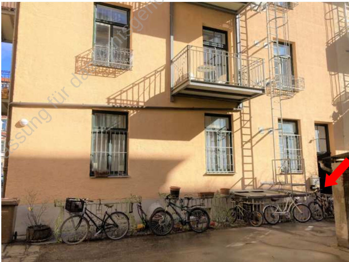
Foto 13: Außenzugang zum Lager Nr. 17
