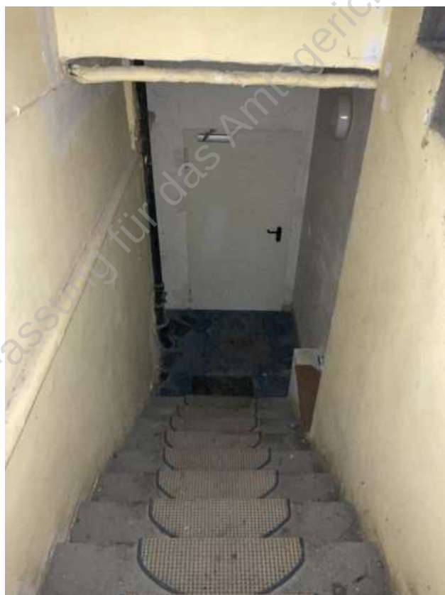
Foto 8: Treppenabgang ins Untergeschoss
