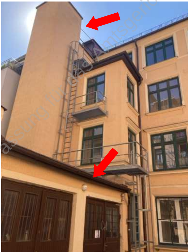
Foto 4: Rückgebäude Lastenaufzug u. Remise
