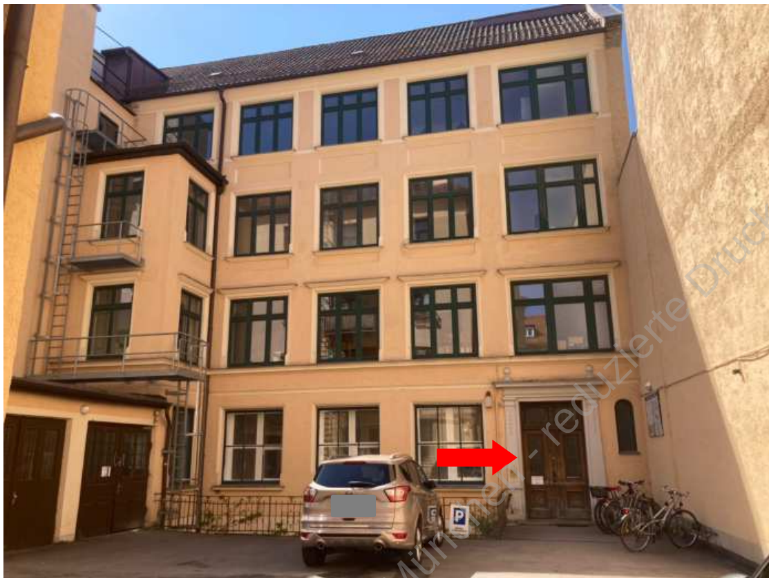
Foto 3: Rückgebäude Nordfassade, Hauseingang
