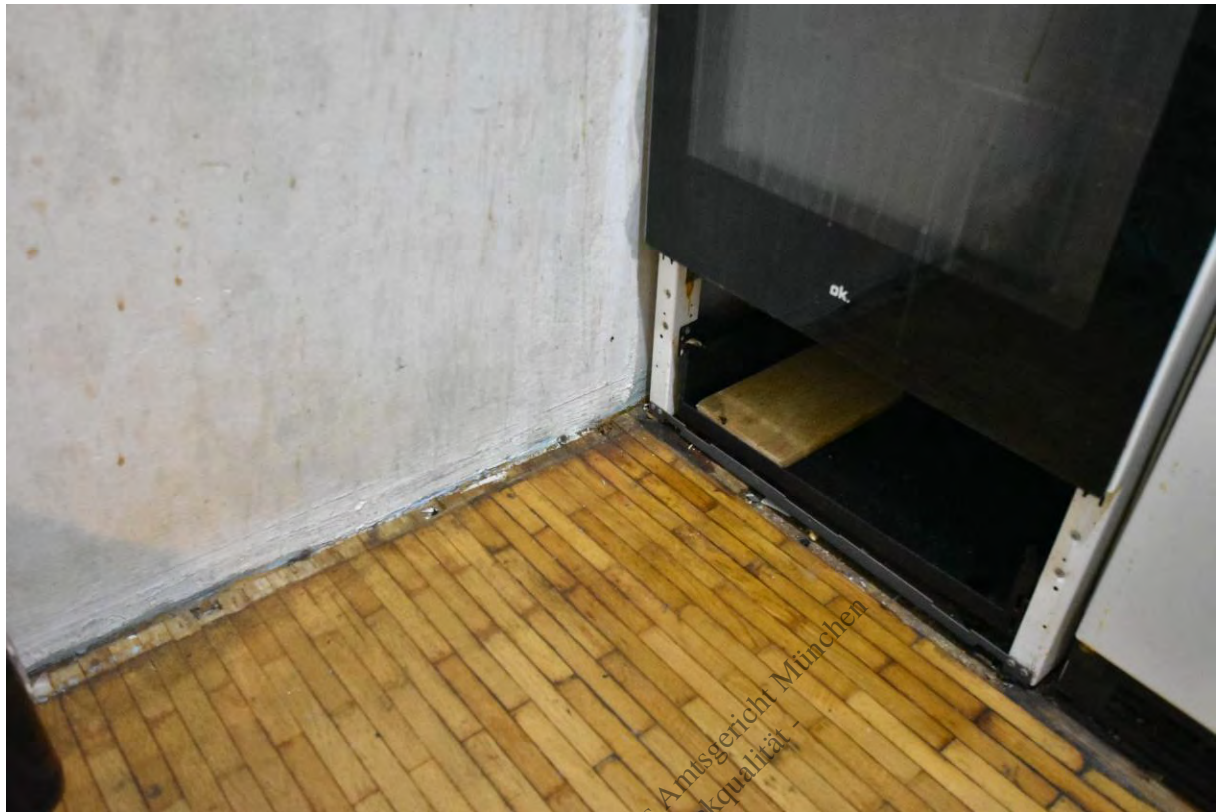
16. Tlw. abgenutztes/aufgequollenes Parkett sowie fehlende Wandanschlussleisten (beispielhaft)
