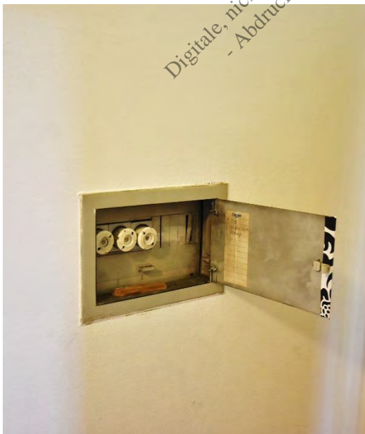
17. Sicherungskasten
