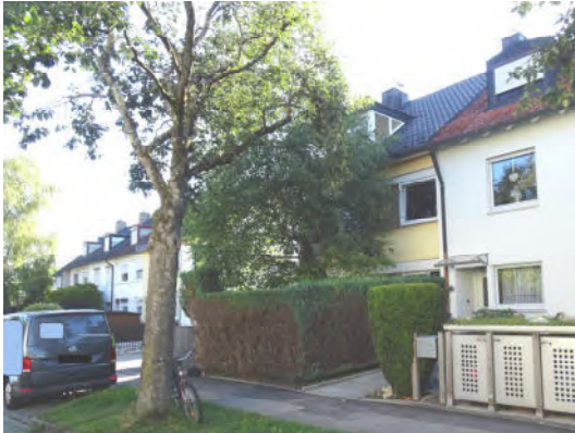
Nordwestseite des Reihenhauses
